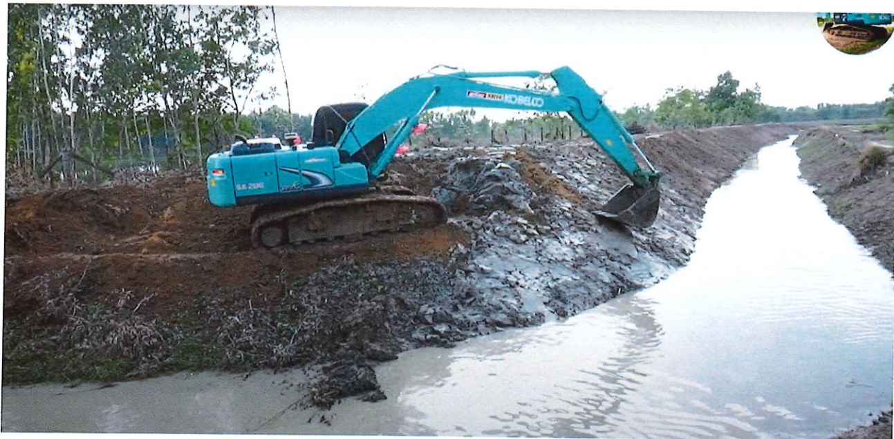
รูปที่ 5 แสดงลักษณะการตักและตักแต่งสันคลองสาธารณะ
